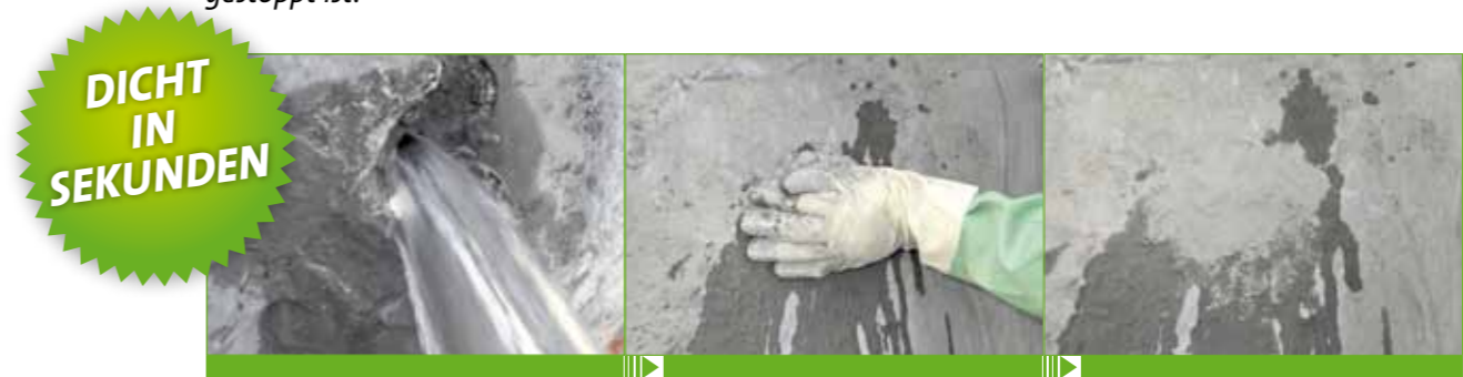
Eine Fließstelle wird mit KÖSTER Kellerdicht 2 Blitzpulver blitzschnell und dauerhaft abgedichtet.
