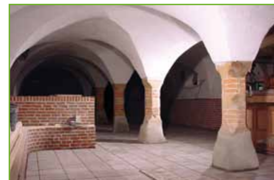
Das Mauerwerk dieser Gebäude wurde mit KÖSTER Sanierputz z weiß instand gesetzt.
