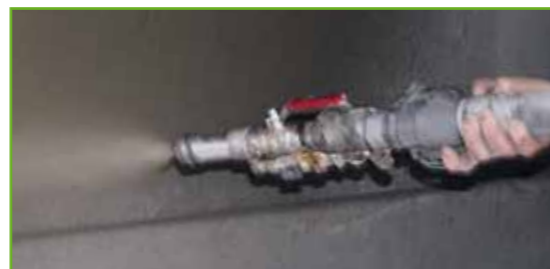
KÖSTER NB 1 grau kann entweder mit einer Bürste aufgebracht oder zum Beispiel mit der KÖSTER Variojet aufgespritzt werden.
