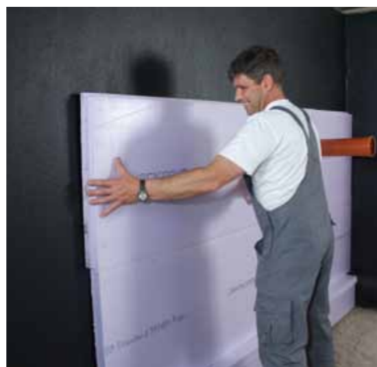
Mit KÖSTER Deuxan® Dämmplatten-Kleber lassen sich Dämmplatten leicht an der Abdichtung befestigen. Wichtig ist dabei eine vollflächige Verklebung.
