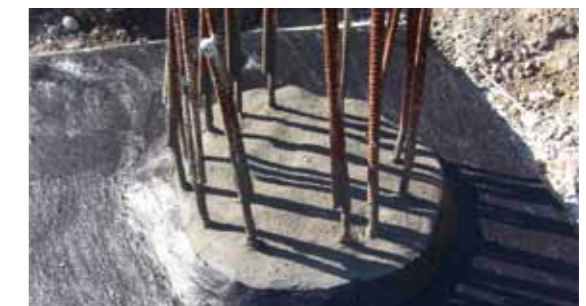
Anschluss der Flächenabdichtung (KÖSTER Deuxan®) an die Abdichtung des Pfahlkopfes.
