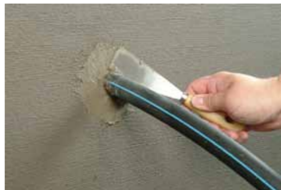
Die Kabeldurchführung ist nun dauerhaft abgedichtet. Um die Abdichtung zu schützen, wird die Fläche mit KÖSTER KB-Fix 5 verspachtelt.
