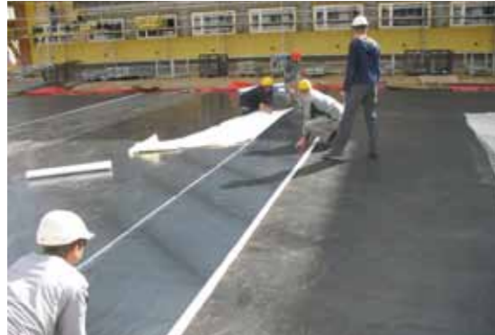
Abdichtung mit KÖSTER KSK Dichtungsbahnen
