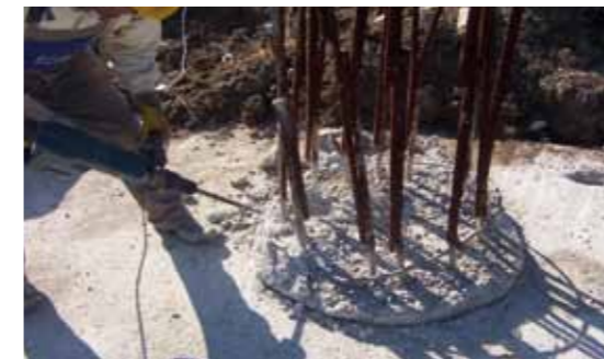
Entfernen von überstehendem Beton und Reinigung der Oberfläche.
