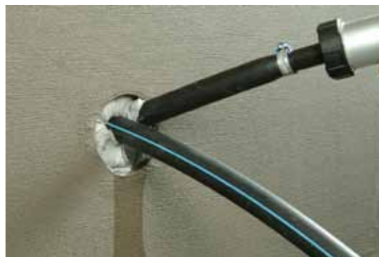
Anschließend wird KÖSTER KB-Flex 200 mit der KÖSTER Hand-Pistole in den Zwischenraum gepresst.
