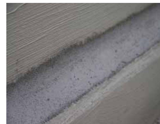
Ausgerundete Hohlkehle aus KÖSTER Sperrmörtel
