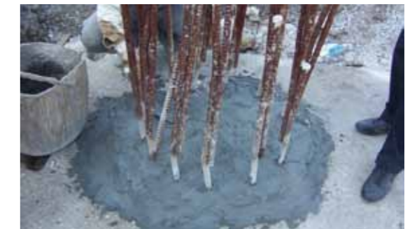
Ausarbeitung einer Hohlkehle und Ausgleichen der Oberfläche mit KÖSTER Sperrmörtel.
