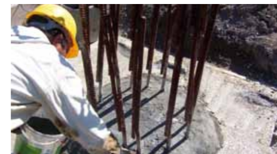
Abdichtung des Pfahlkopfes mit KÖSTER NB 1 grau.
