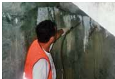
Injektion im Niederdruckverfahren
