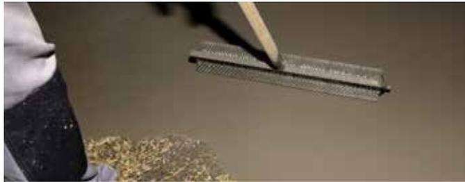
6 Abschließend das Material mit einer Stachelwalze entlüften
